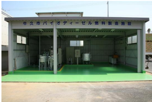
【BDF燃料製造施設】(21年3月完成・4月稼働)
