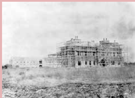
明治35(1902)年頃、建設中の旧事務室。
