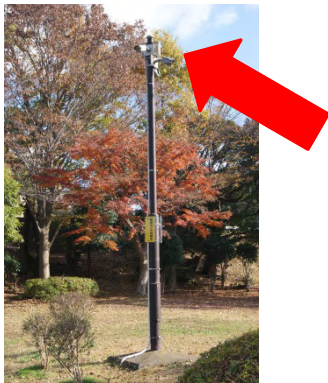
防犯・安全設備（防犯カメラ）
