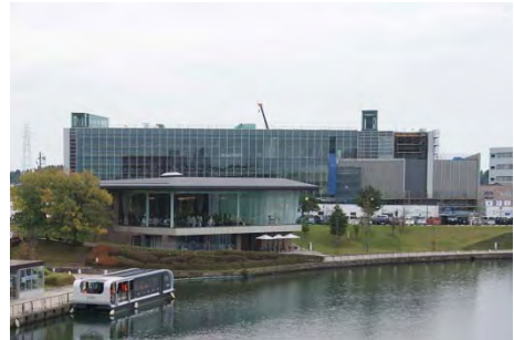
建設中の富山県美術館（後方）
