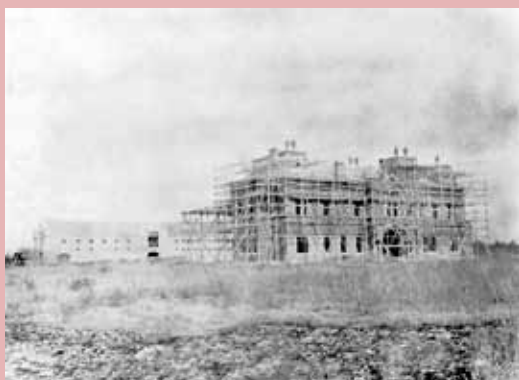
明治35(1902)年頃、建設中の旧事務室。
