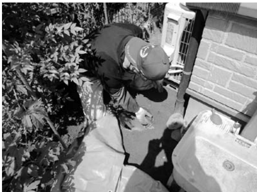
雨水マスの除染作業
