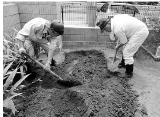
除去土壌の埋設作業
